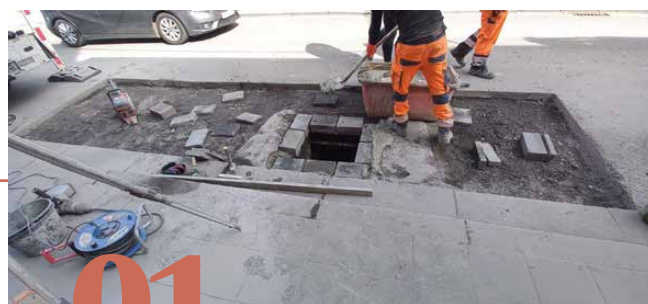
Réparation d'une chambre de visite & asphaltage Rue Vallaville.
