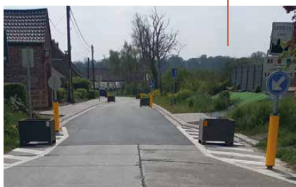
Finalisation des travaux de rénovation de l'Avenue B. Thiennes à Lombise avec le placement de la signalisation et de bacs à fleurs dans les chicanes.
